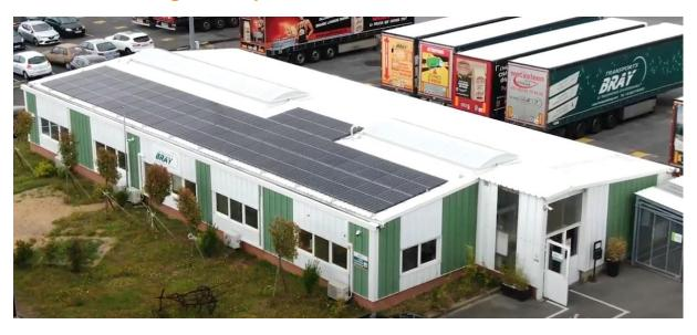
Installation photovoltaïque : 295 panneaux solaires ont été installés sur les deux bâtiments de l'entreprise (+800m2 de toiture), générant une puissance de 110 kWc et couvrant une surface de 537 m2. Cette installation permet à Transports BRAY de couvrir 50% de ses besoins en électricité. La mise en service a eu lieu le 11 juillet 2023.
